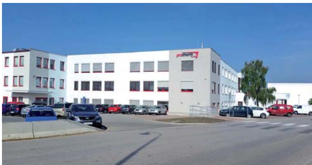
Pohľad na novú administratívnu budovu spoločnosti Protherm Production
